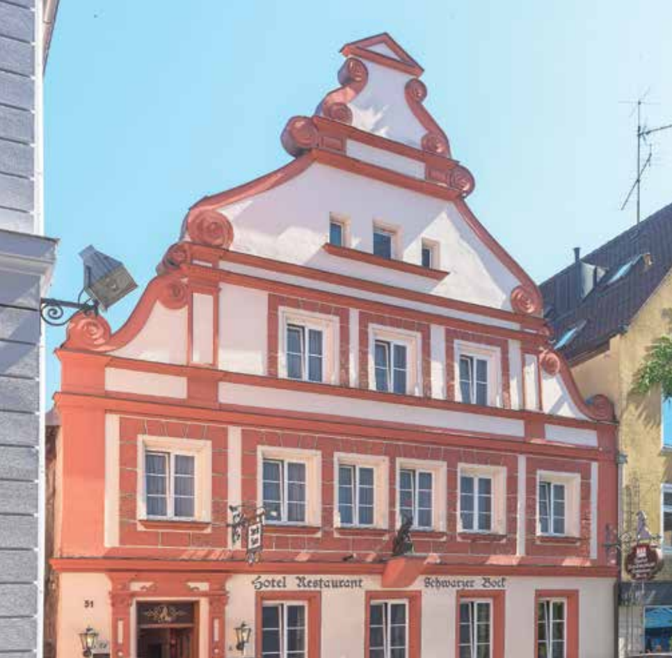
Das Hotel „Schwarzer Bock“ profitiert seit fünf Jahren von den Vorzügen eines Blockheizkraftwerks.
